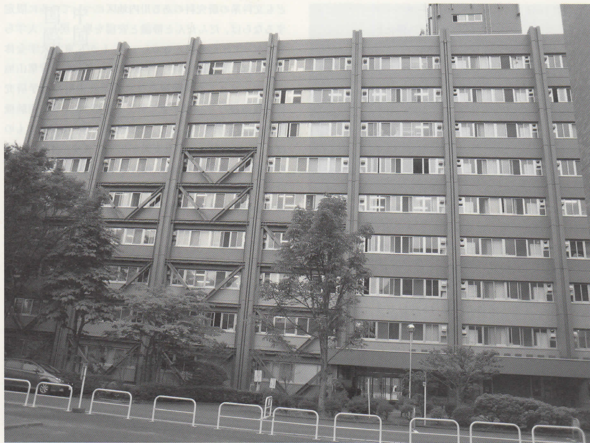
写真1 東北大学文学研究科棟の鉄骨ブレース(花登正宏撮影)
